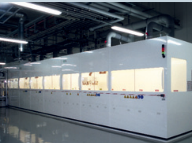
STANGL Nassprozessanlagen, ausgeführt als "Vertikales Batch System" bilden den Grundstock einer effektiven und kostengünstigen Massenproduktion von Mono- und Multi-Kristallinen Wafern
